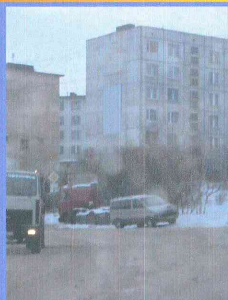
На фасаде д. 71 по ул. Советская, в г. Гаджиево (вид с развилки ул. Ленина – ул. Колышкина).
