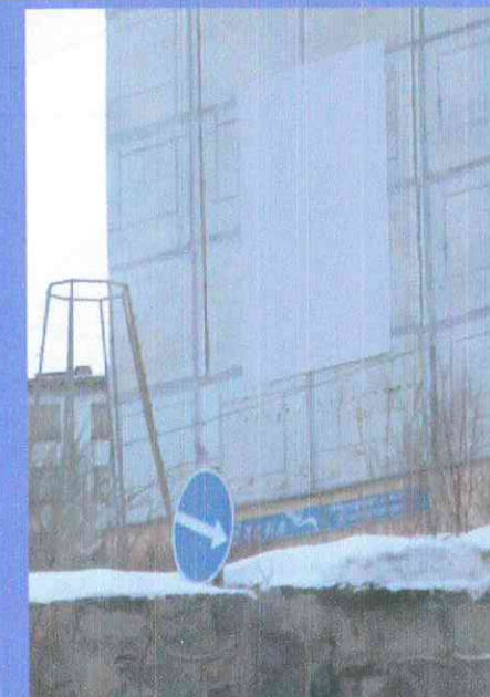
На фасаде д. 71 по ул. Советская в г. Гаджиево (вид при въезде на ул. Советскую).
