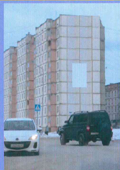
На фасаде д. 130 по ул. Колышкина в г. Гаджиево в 100 м до въезда на придомовую территорию.
